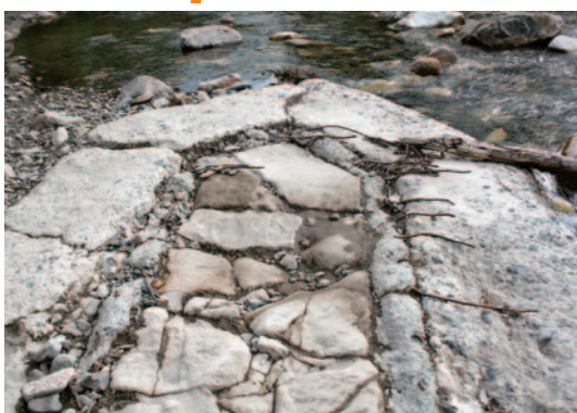
中央部(内側)に大きな石を詰めている
