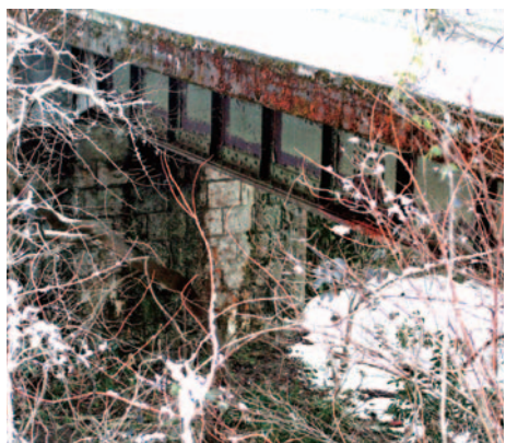
トンネルの手前にある、筥ノ川にかかる橋。石積みの橋台などは鉄道時代のものを使用しているという
