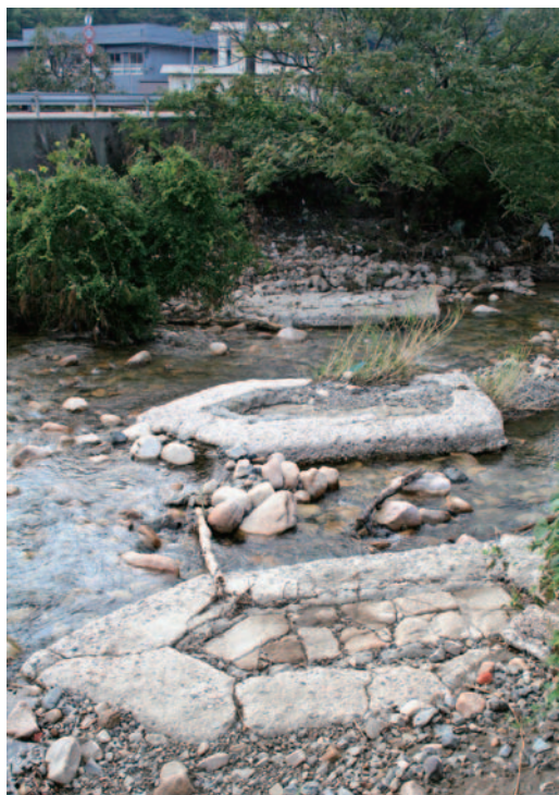
3基見える「土台」。左が上流で、上流側がとがっている(曾々木方面から見る)
